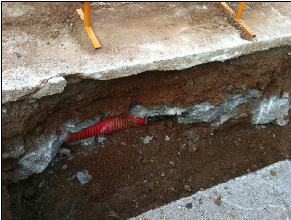
Fig. 8. Vista de part de la zona A del Tram 2
