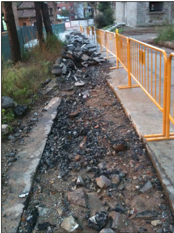
Fig. 7. Vista del Tram 2 un cop picat l'asfalt i la preparació (UE 201 i 202)
