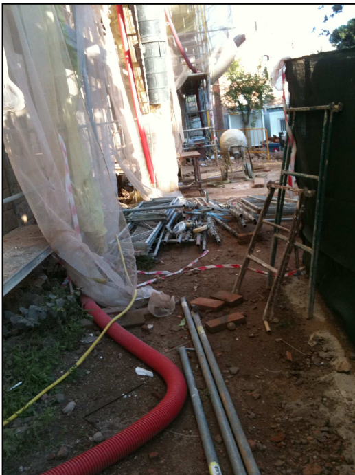
Fig. 4. Vista de zona on s'obrirà la rasa- Tram 1
